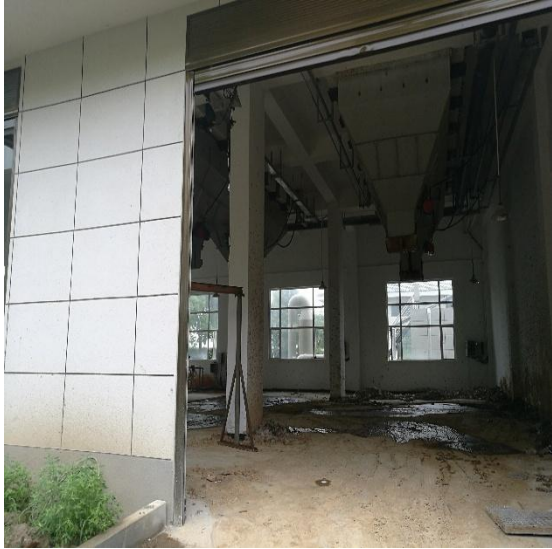
污泥脱水车间
