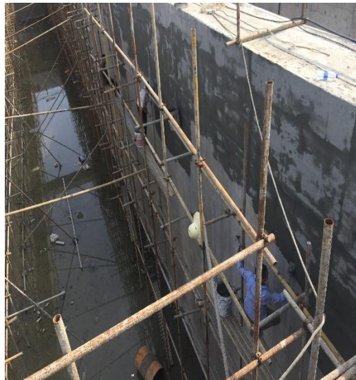
池面防渗防腐铺设
