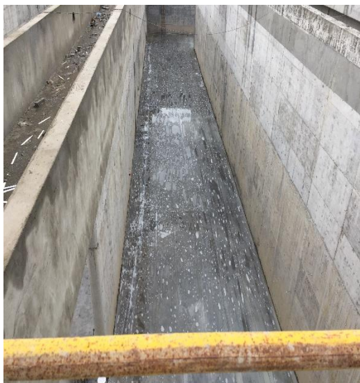
池底防渗防腐层
